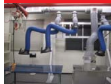
分解・洗浄室
